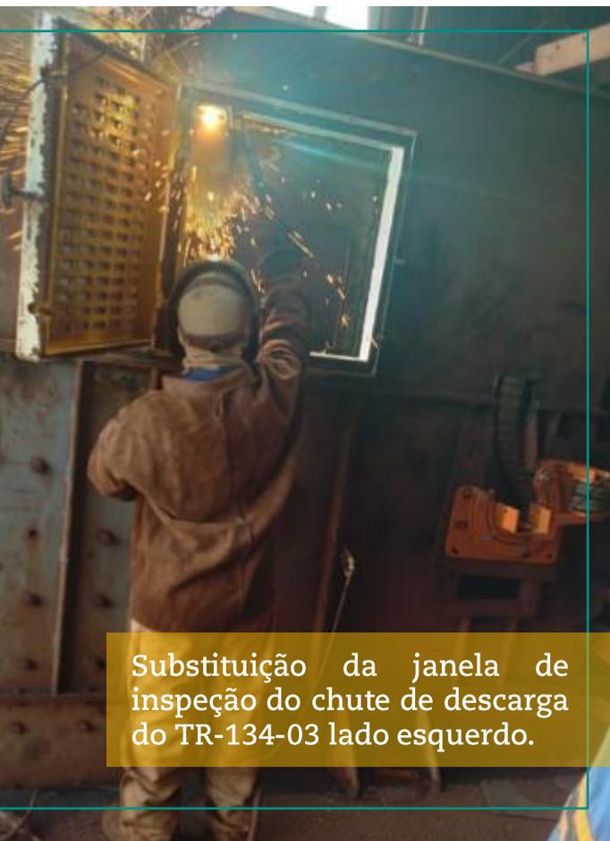
Substituição da janela de inspeção do chute de descarga do TR-134-03 lado esquerdo.
