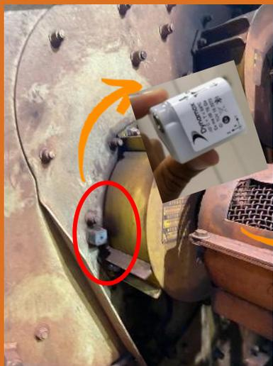
Sensor triaxial sem fio instalado
