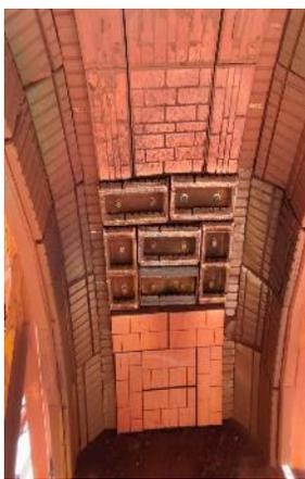
Instalado painéis de revestimento para formação de morto, eliminando os vazamentos nessa região e consequentemente redução de horas de manutenção corretiva neste ativo. CHUTE DA TR 131-02.
